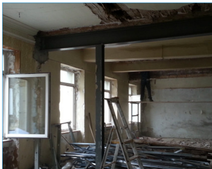
Des surprises lors des travaux d'aménagement de la mairie, deux poutres en bois ont du être remplacées par des poutres métalliques.
